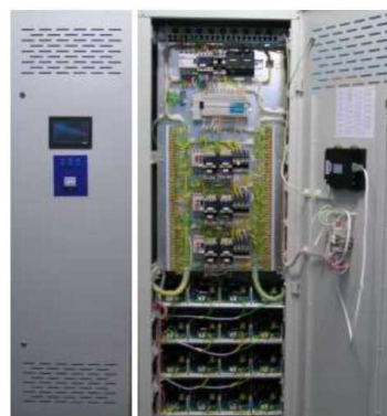
Рисунок 1.6. Шафа управління ЗВ8КС.02, що забезпечує одночасну роботу трьох знезаражувальних касет В8КС.01
