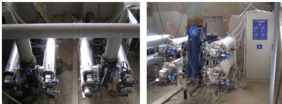
Рисунок 1.4. Установка для знезараження стічних вод корпусного типу продуктивністю 500 м 3 /год із системою механічного очищення кварцових чохла
