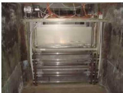
Рисунок 1.7. Знезаражувальні касети В6КС.01 із вбудованим механізмом очищення кварцових чохлів
