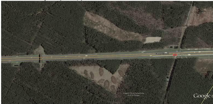
Зелений міст та тунель (Польща).
