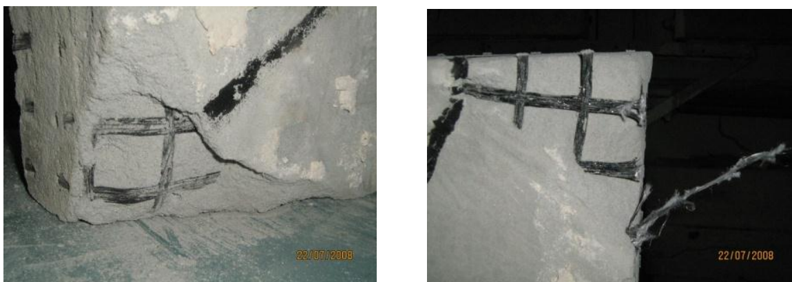
Рис. 3.24. Вигляд процесу розколювання плит марок П-19, 20 в площинах розміщення сіток «Armtex».
