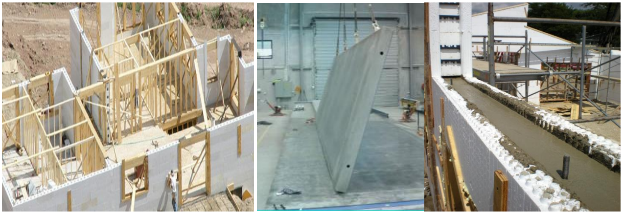
Рис 1.6: а) зовнішнє заповнення в каркасному будинку [136]; б) внутрішні перегородки – панелі з легкого ніздрюватого бетону [109]; в) монолітні стіни [110]
