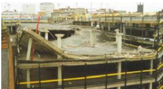
Рис.1.14. Явище продавлювання з фотофіксацією руйнувань
