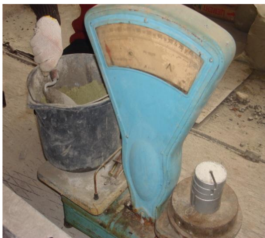
Рис. 2.2. Зважування компонентів для виготовлення пінобетону.
