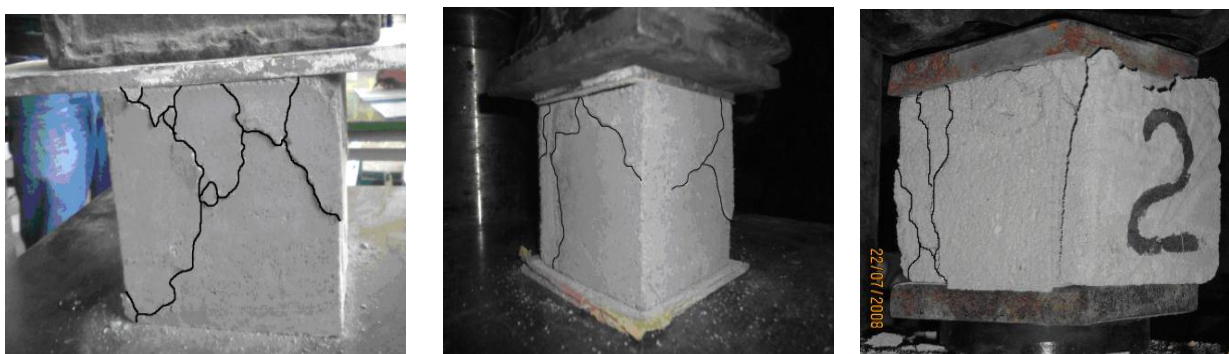
Рис. 3.26. Утворення тріщин в приопорних зонах.
