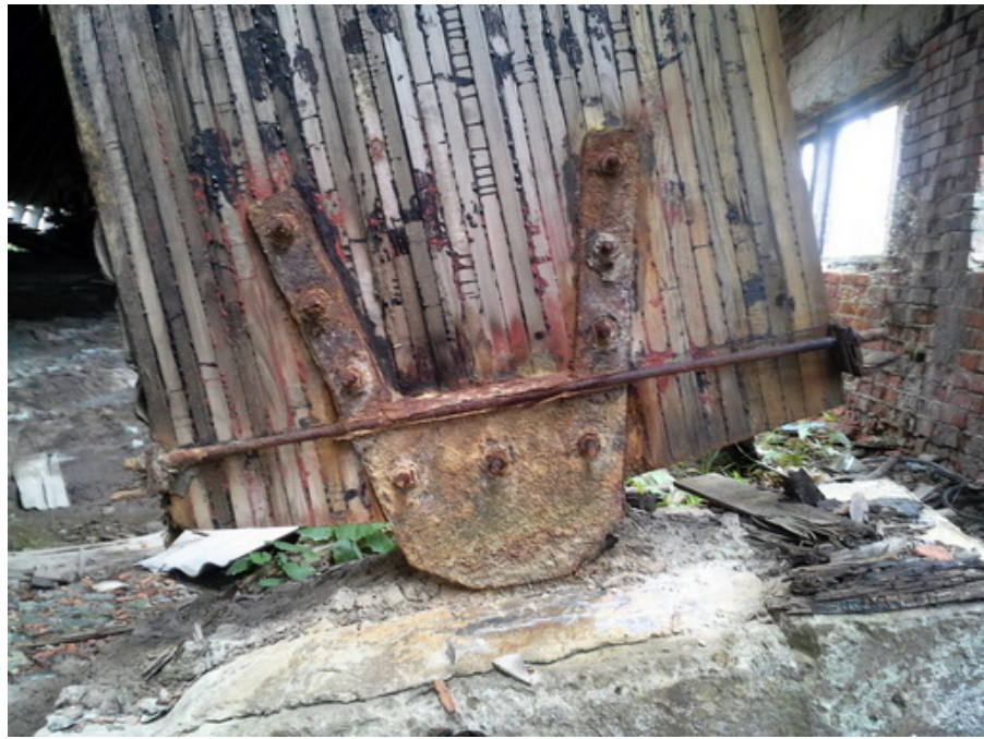
Рис. 1.3. Опорна частина дощатоклеєної арки дробильного цеху мінеральних добрив.
