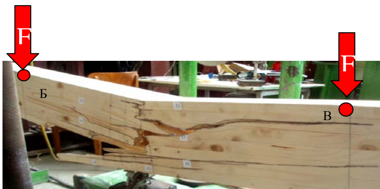
Рис. 6. Вигляд балки БД-1 після руйнування.
